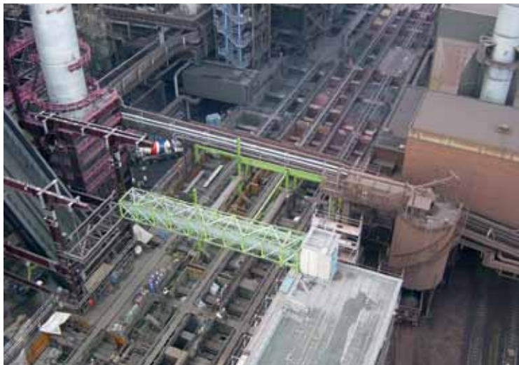
2 Übersicht der Hochbahn-bunkeranlage (ohne Entstaubungsanlage)
