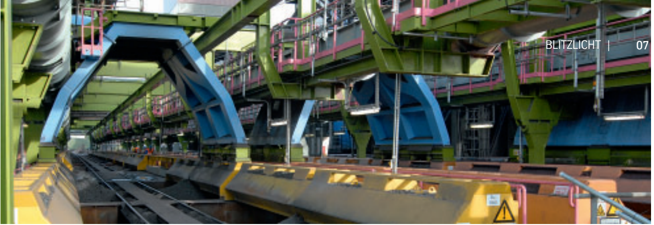
Hochbahn | Mobiles Stauberfassungssystem. Foto: Uhde Services
